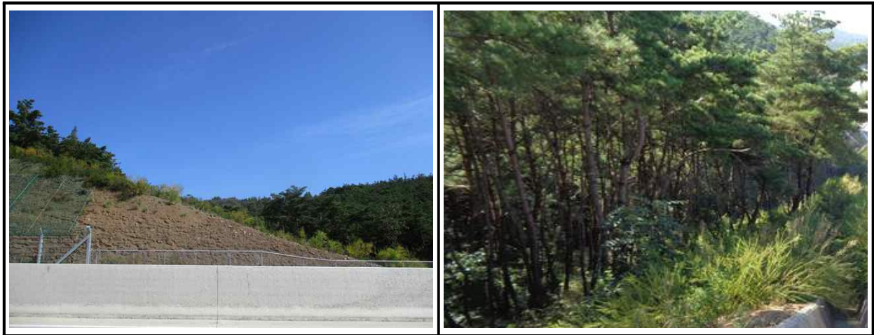
【그림 65.3.1】 상부자연사면 전경
