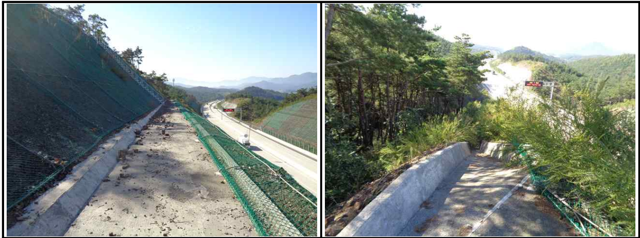
【그림 65.3.3】 배수시설 전경
